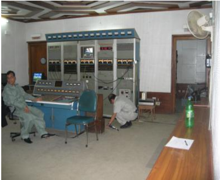
マスターコントロールルーム
