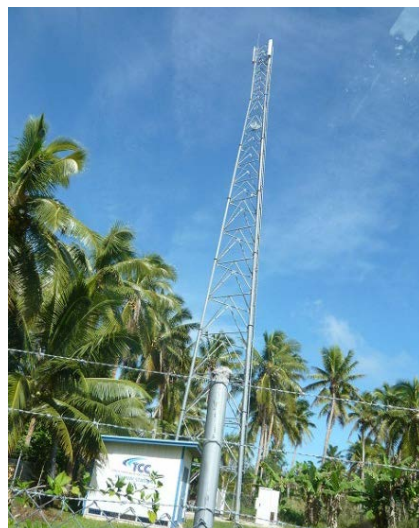
現地携帯通信会社の鉄塔
