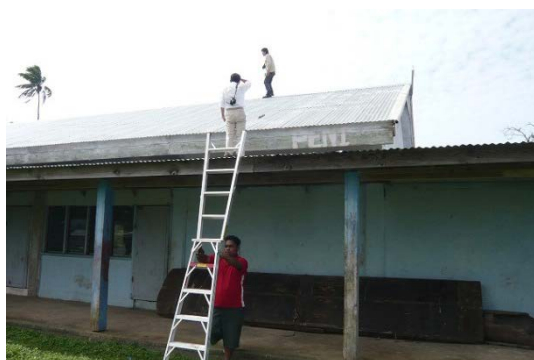
屋上から無線区間の見通し確認
