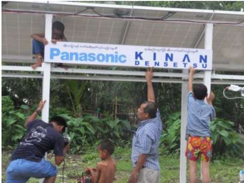
ソーラーパネル工事完了
