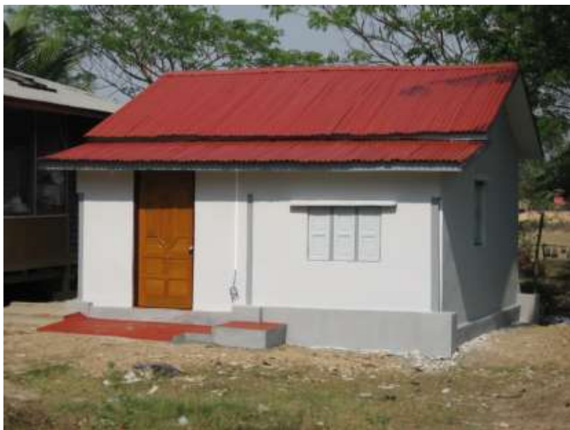
補修後の外観
