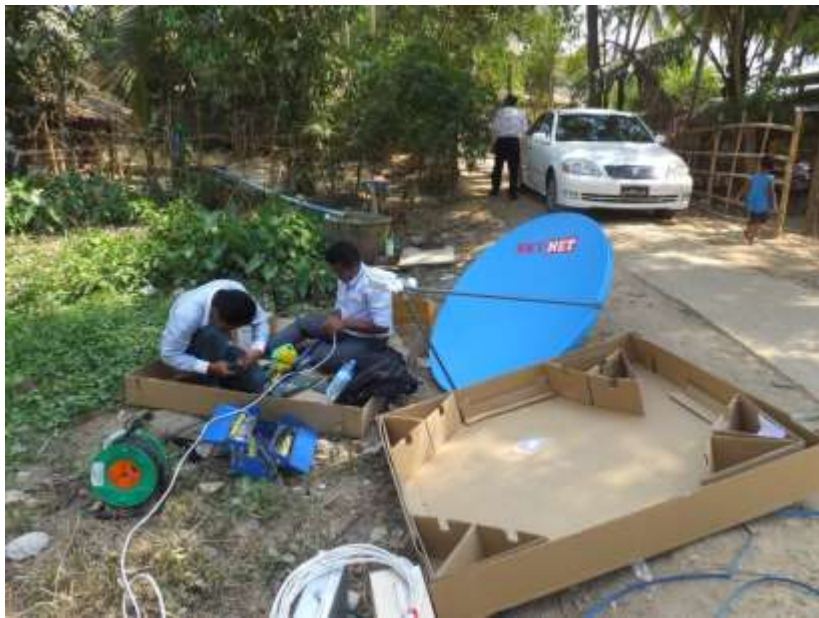
VSATアンテナの組み立て
