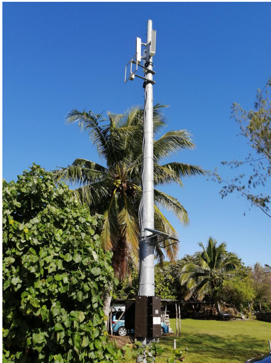
コンポーネント2用の屋外サイレン子局（ニウアトプタプ島）
