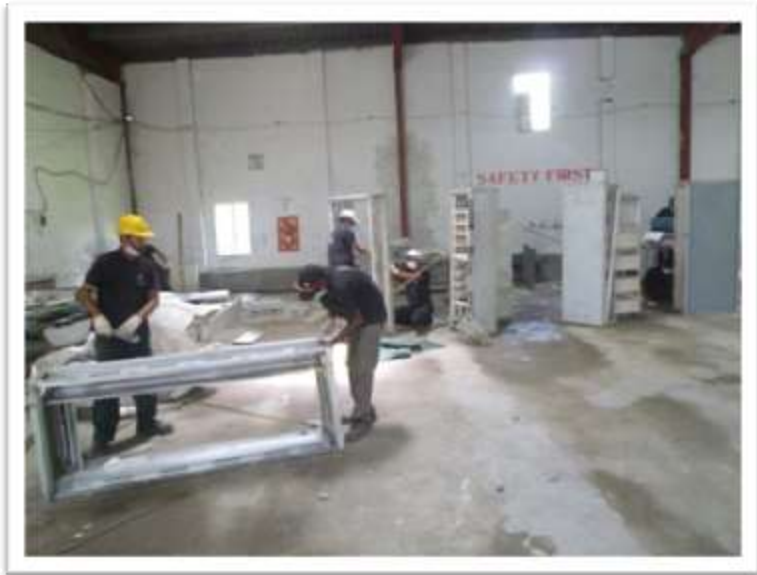
鉄枠の解体を行っている。
