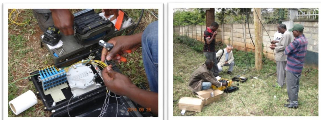
図表 30 光ケーブル接続作業（左）とケーブル布設作業（右）
